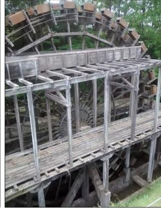
Figura 2: Rueda del Fundo de San Roberto en funcionamiento, su diseño se basó en las azudas de Larmahue. Fuente: Autora, 2015.
