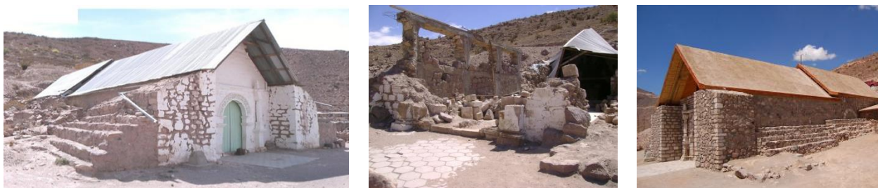
Figura 9. De izq. a derecha: Iglesia de Usmagama antes del terremoto del año 2005; después del terremoto del 2005; y luego de su restauración el año 2010
