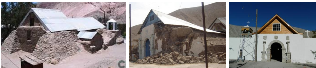
Figura 5. De izq. a derecha: Iglesia de Laonzana antes del terremoto del año 2005; después del terremoto del 2005; y luego de su restauración el año 2012
