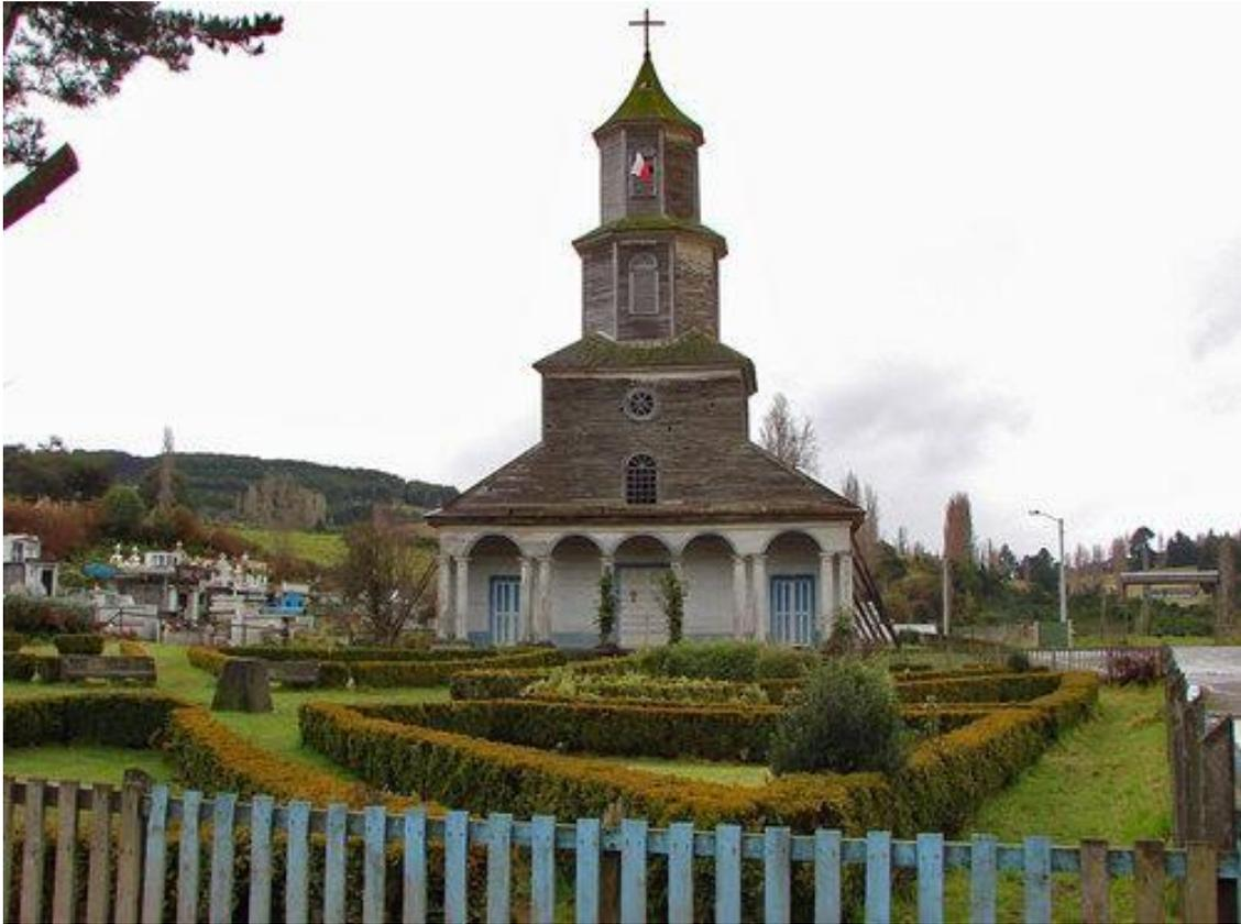
Construida a mediados del siglo XIX. Se encuentra a algunos kilómetros de la comunidad de Castro. Los materiales empleados son: en la base piedra y maderas de ciprés; estructura ciprés y coigüe; revestimiento interior tablas machihembradas; techumbre tejas de alerce; revestimiento exterior traslape de ciprés.<sup>124</sup> Su estilo es neo-clásico debido a que mantiene la simetría de la torre-fachada en armonía con la doble columna y los cinco arcos.
