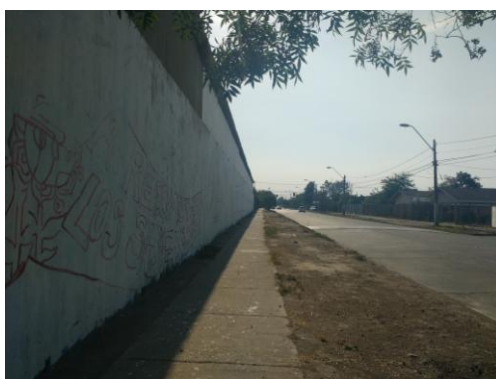
Imagen 18. Muro exterior Centro de Internación Provisoria del Sename
